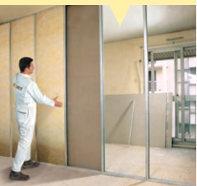
Встановлення перегородок.
