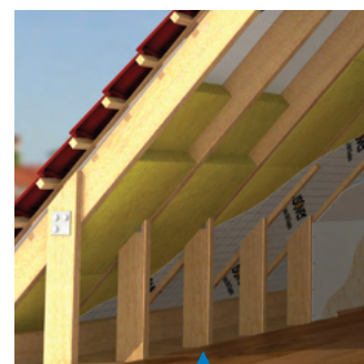
Теплоізоляція розміщена в міжкряквяному просторі
